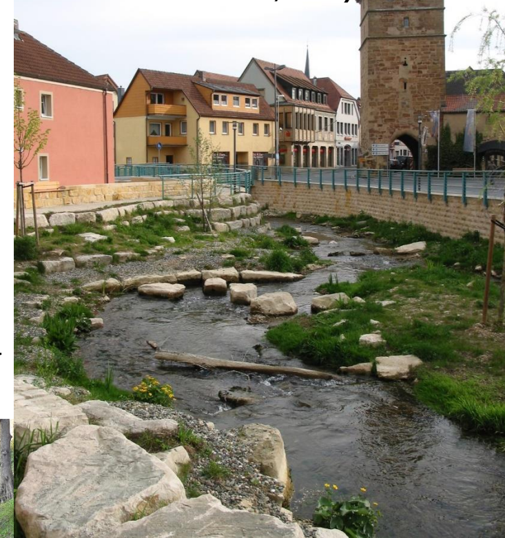
Revitalizace potoka Lauterbach v bavorském Bad Staffelstein (2011), pronikla až na historické náměstí. Lidé mohou sestupovat k vodě a sedat si na schodišťově uspořádané kamenné kvádry. Foto T. Just, zdroj metodika Just a kol., 2020).
